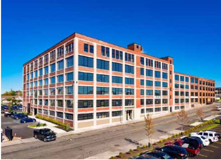
الشكل (١-١٩): مجمعٌ تجاريٌّ.
